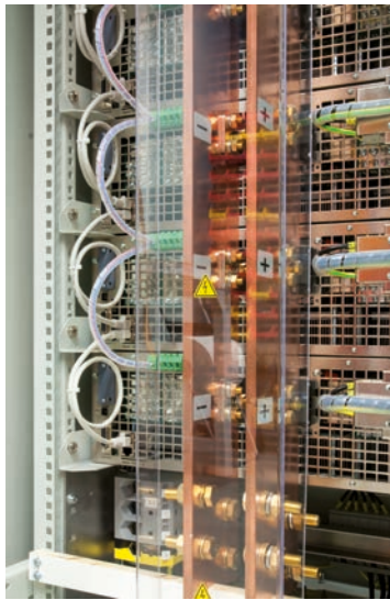
DC-Anschluß / DC bus terminal
